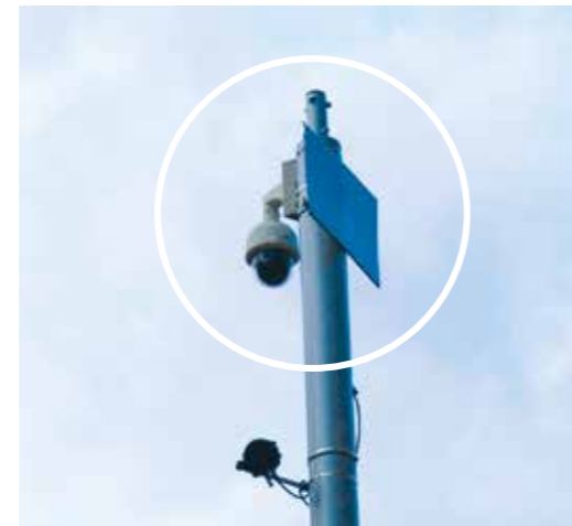
Fot. 1 i 2. Privacy by design . Fizyczny ekran przysłaniający pole widzenia kamery jako skuteczny sposób zapewnienia „strefy prywatności” i przekazania informacji o jej stworzeniu
