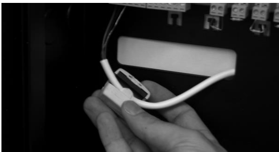
Rysunek 28 – Zakładanie rdzeni ferrytowych na przewody pętli
